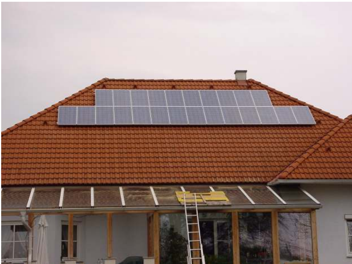
Netzverbundanlage Aufdach, 2,88kWp
